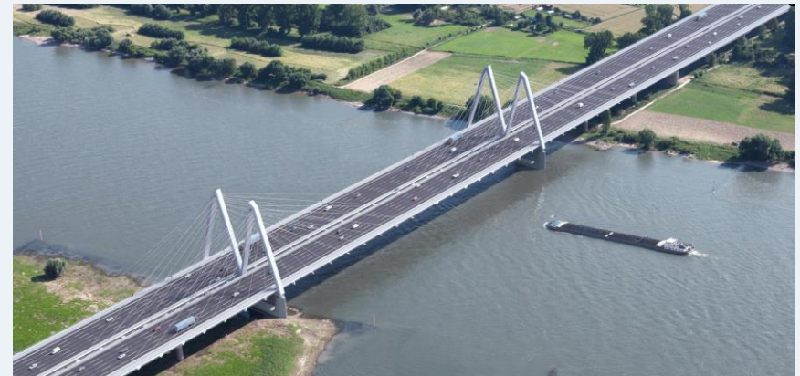
BAB A1 / 8-streifiger Ausbau zwischen AS Köln-Niehl und AK Leverkusen-West (einschl. Ersatzneubau der Rheinbrücke)
