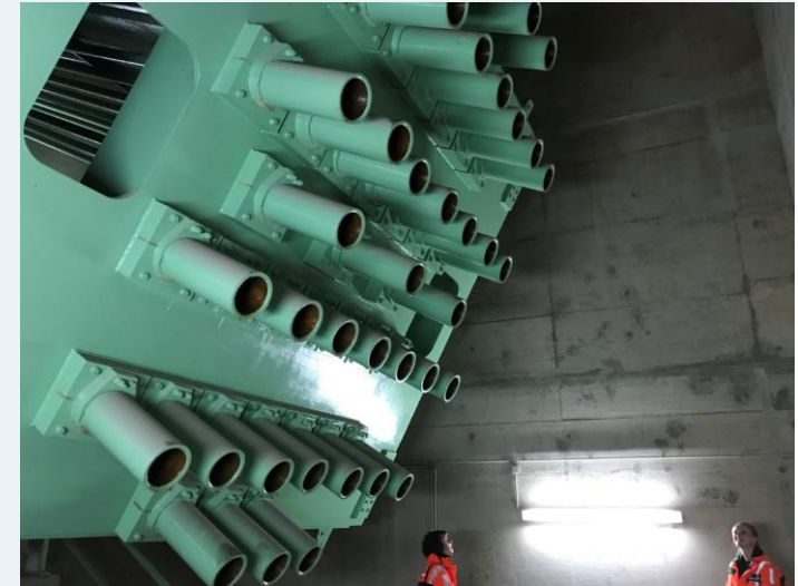
Bild: Seilverankerung Rheinbrücke Rodenkirchen
